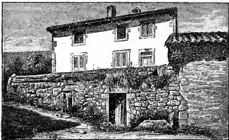
MAISON DE LA FAMILLE DESCHAVANNES
